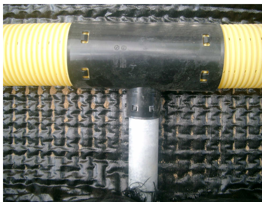
Rysunek 6 Połączenie rury drenażowej \Phi 100\text{ mm} z rurką \Phi 50\text{ mm}
