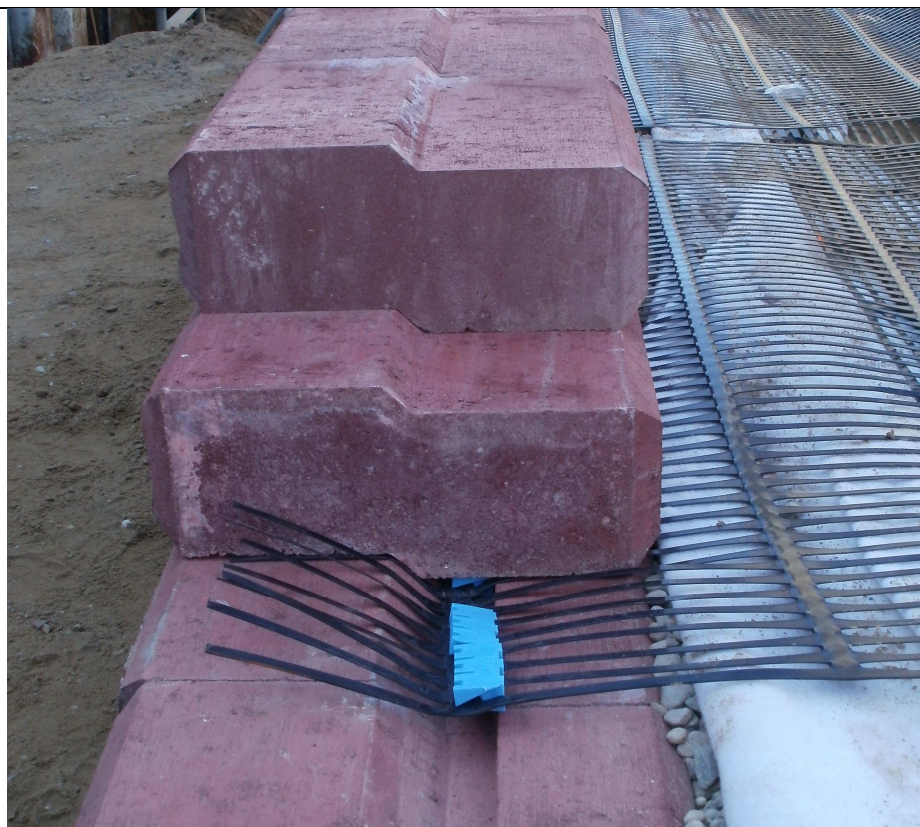
Rysunek 3 Mocowanie georusztu i łącznika typu connector
